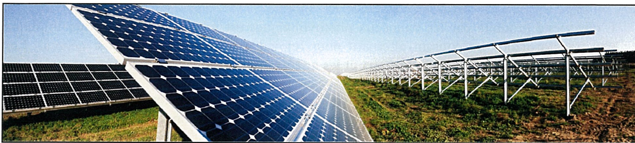
Exemple de rangées de panneaux en construction
